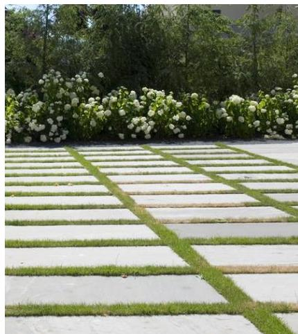
Dallage béton à joints enherbés
