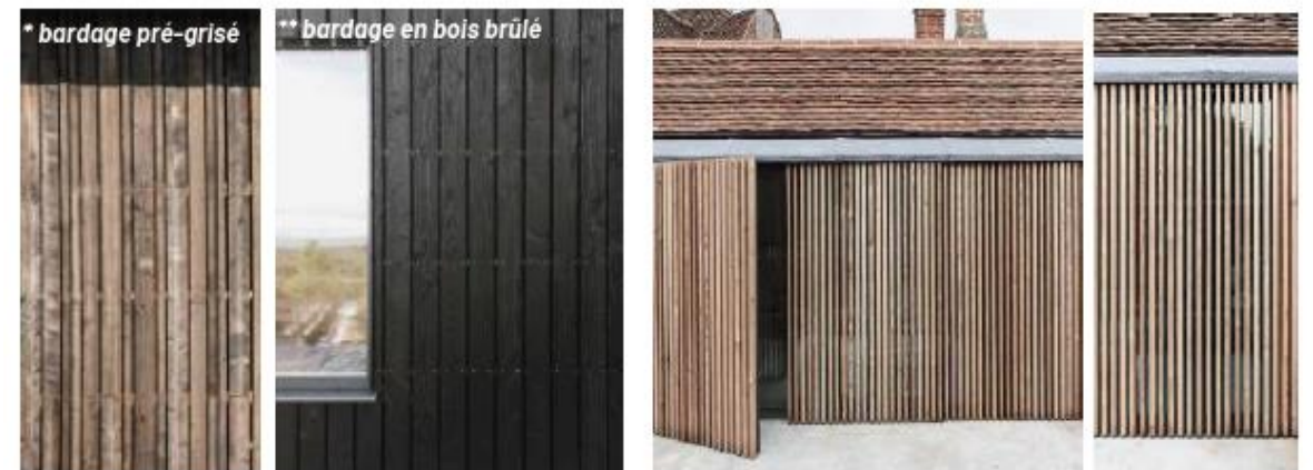
> Le choix d'une trame plus contemporaine, à claire voie ou à emboîtement, permet de moderniser sobrement les façades.
