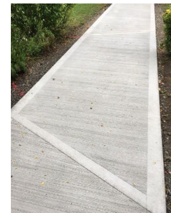
Béton balayé coffré et coulé en place avec bordure lisse
