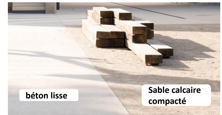
Béton balayé coffré et coulé en place avec bordure lisse
