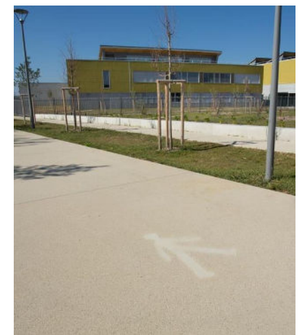
Béton finition sablée avec pochage de logo béton lisse
