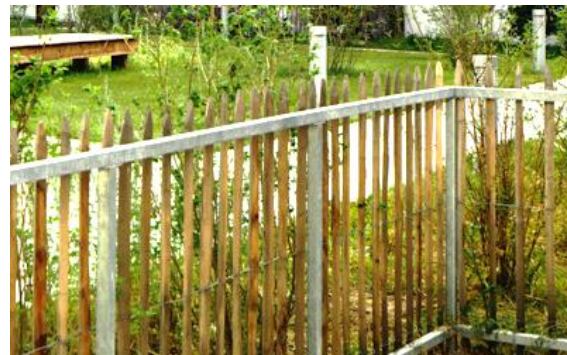
Ganivelles + structure métallique
