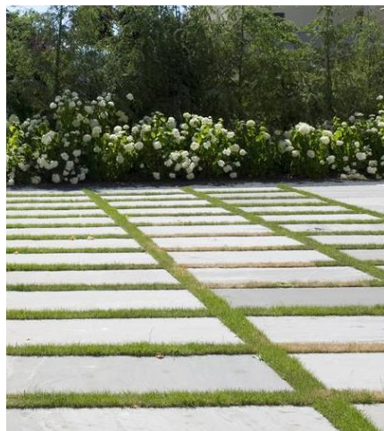
Dallage béton à joints enherbés
