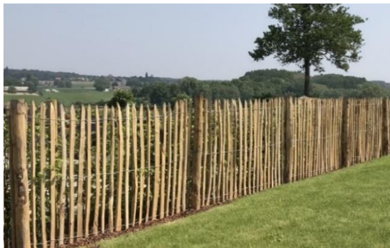
Ganivelles + poteaux bois et fils métalliques
