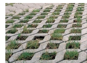
Dalles alvéolaires béton enherbées
