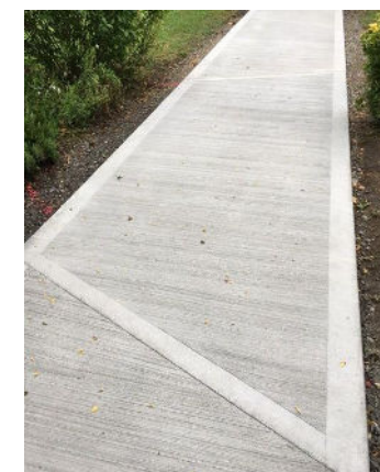
Béton balayé coffré et coulé en place avec bordurage lisse
