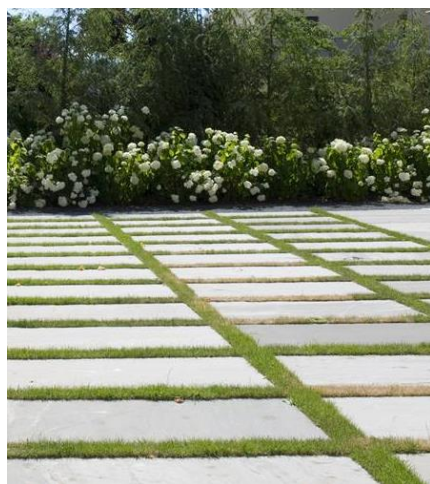
Dallage béton à joints enherbés
