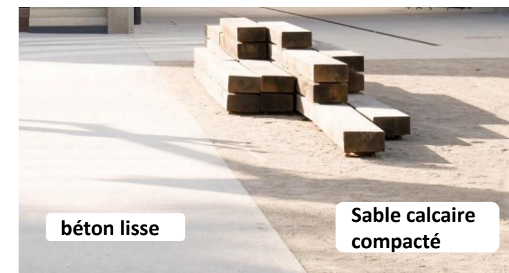
Béton balayé coffré et coulé en place avec bordurage lisse
