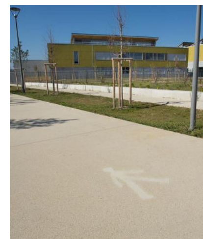
Béton finition sablée avec pochage de logo béton lisse
