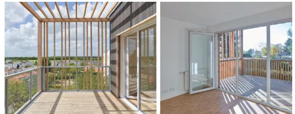
Architectes Tetrarc, photos © S.Chalmeau
