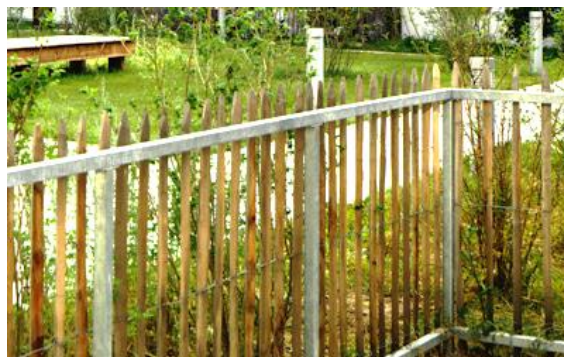
Ganivelles + structure métallique
