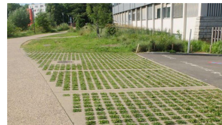
Surlageur de voies de piétonnes traitées en matériaux carrossables enherbés de type bétons alvéolaires, accès pompiers ou autres accès de services
