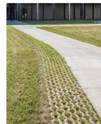
Surlageur de voies de piétonnes traitées en matériaux carrossables enherbés de type bétons alvéolaires, accès pompiers ou autres accès de services
