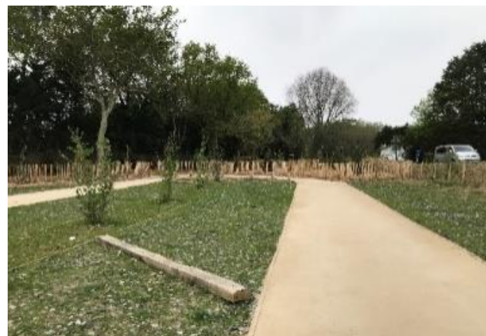
Allée en sables calcaire compacté
