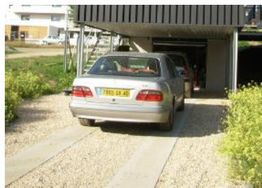
Chemin de roues en béton et grave
