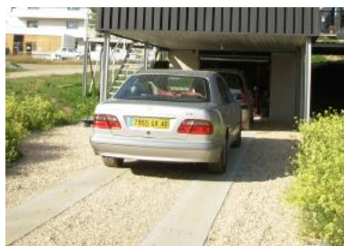
Chemin de roues en béton et grave
